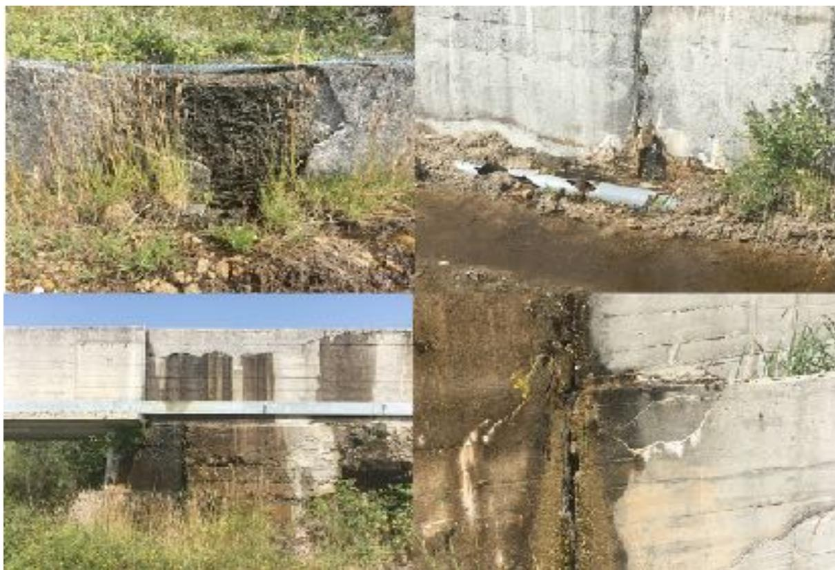
Figura 8. Conduto de água de S. Serrada a Açude das Gralhas (A); conduita de água em cimento aberta, apenas tapada por uma rede, de Açude das Gralhas (B e C) até à camara de carga (D).
