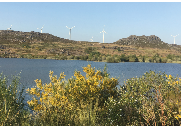
Albufeira da Barragem de Serra Serrada
