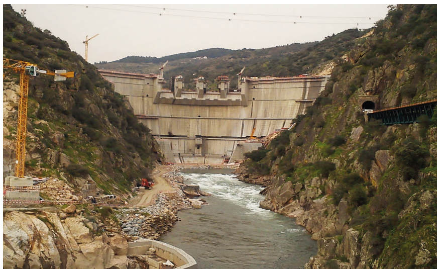
Construção da Barragem de Foz Tua | © GEOTA
